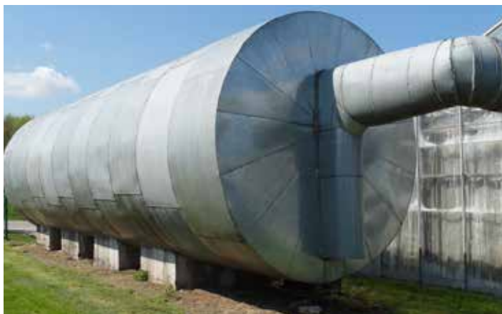
Zasobnik ciepła przyniósł spore oszczędności w ogrzewaniu szklarni
